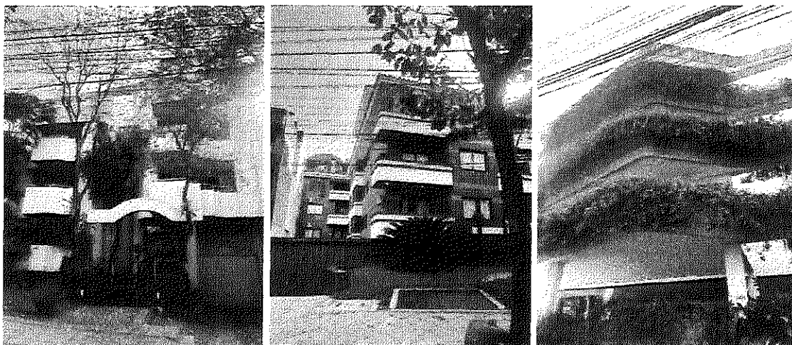
EDIFICIOS RESIDENCIALES SOBRE AVDA. AUGUSTO ROA BASTOS.
