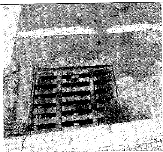
Fotografía 3. Sumidero 2, ubicado sobre la calle Charles de Gaulle.
