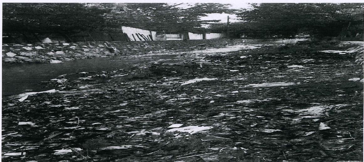
*Punto de acceso para las maquinarias. Se visualizan muros de contención de gaviones en ambos márgenes del cauce. Se observa la formación sedimentos de montículos de arena, formados por la erosión y escorrentía, derivadas del caudal del cuerpo de agua.*
