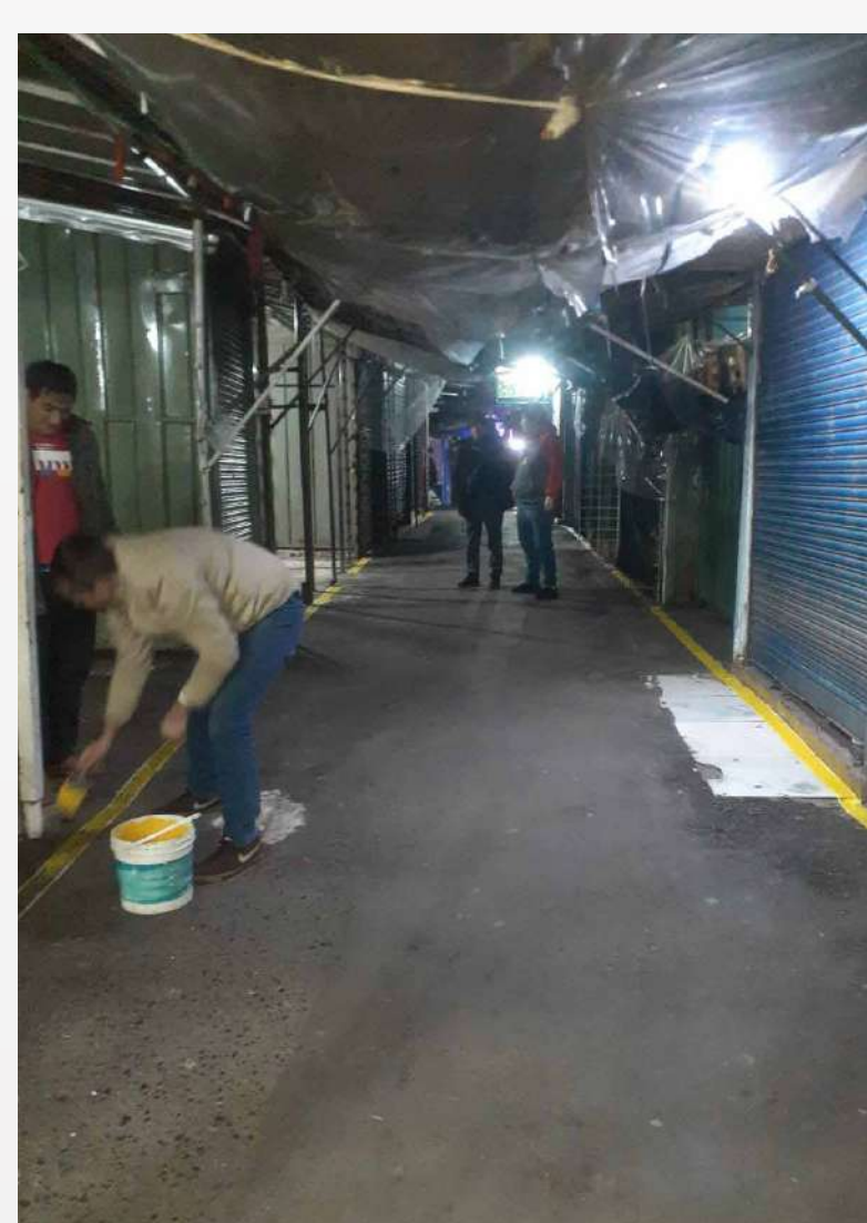
Pintura de espacio permitido - M4
