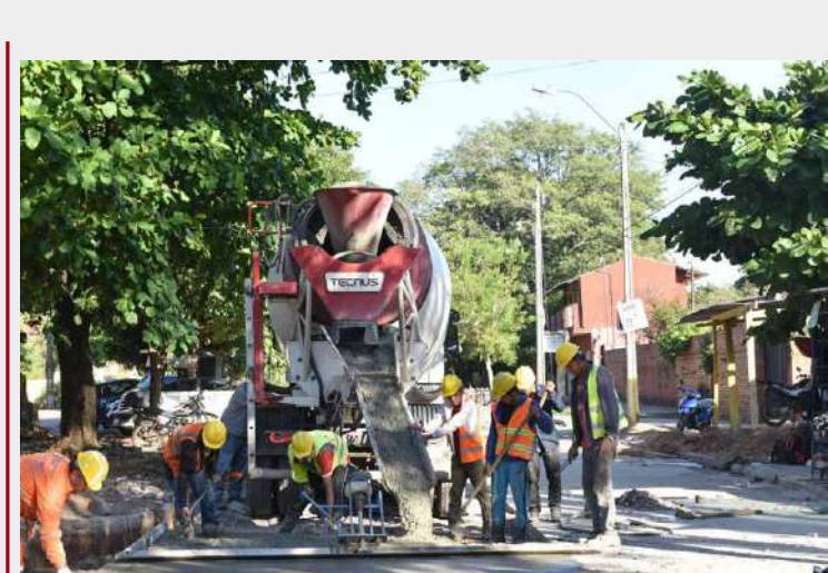
Hormigón hidráulico 36° Ptdas. y Japón
