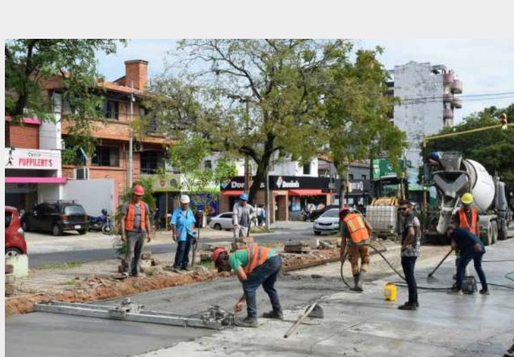
Hormigón hidráulico Av. Carlos A. López
