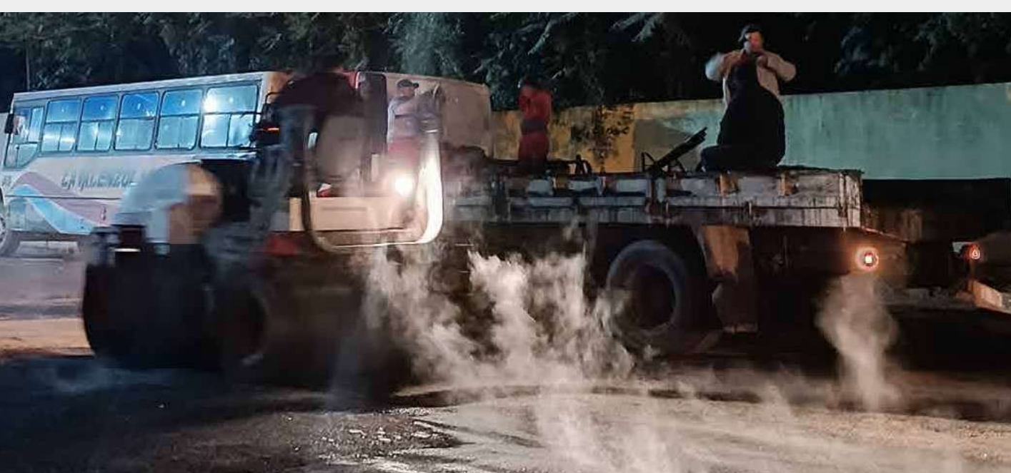
Mejoramiento vial - Estación de Buses de Asunción
