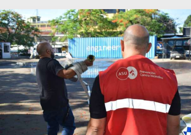
Trabajos de prevención contra incendios
