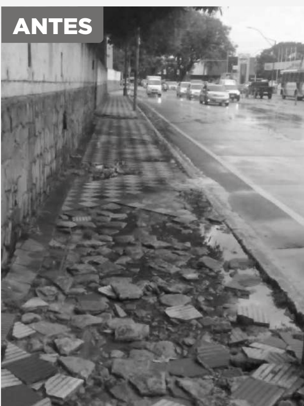
Reacondonamiento, murallas y veredas (Foto del antes)
