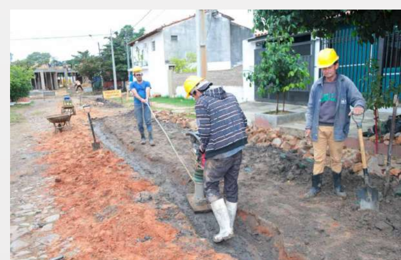
Alcantarillado Sanitario Barrio Salvador del Mundo
