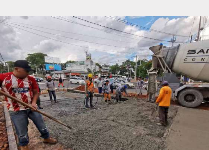
Hormigón hidráulico Av. Fdo de la Mora y Rca. Argentina
