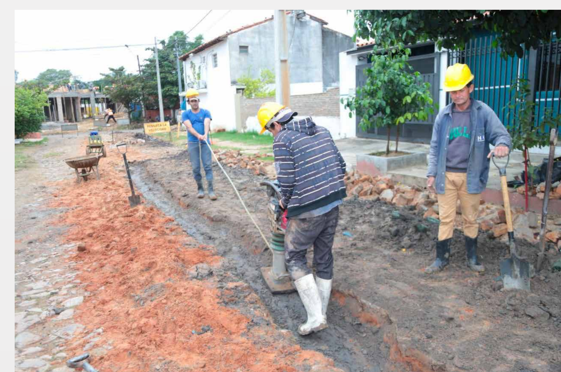
Alcantarillado Sanitario Barrio Salvador del Mundo
