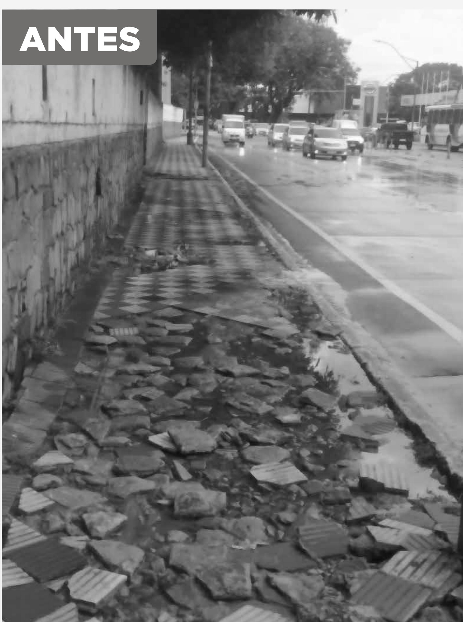
Reacondionamiento, murallas y veredas (Foto del antes)
