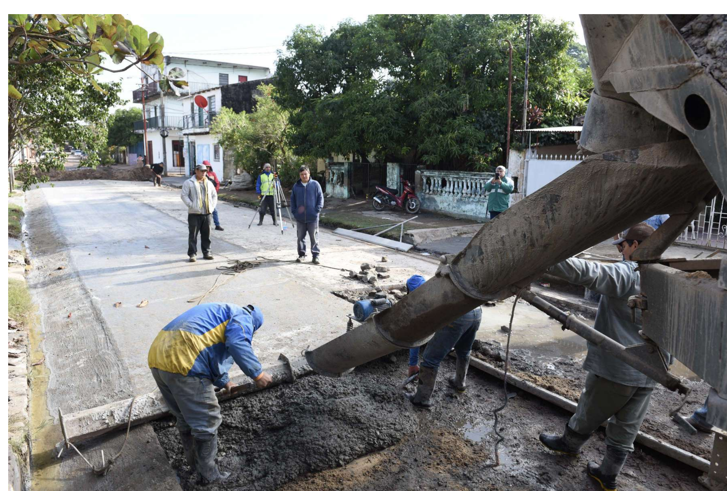
Mejoramiento Vial - Bañado Sur
