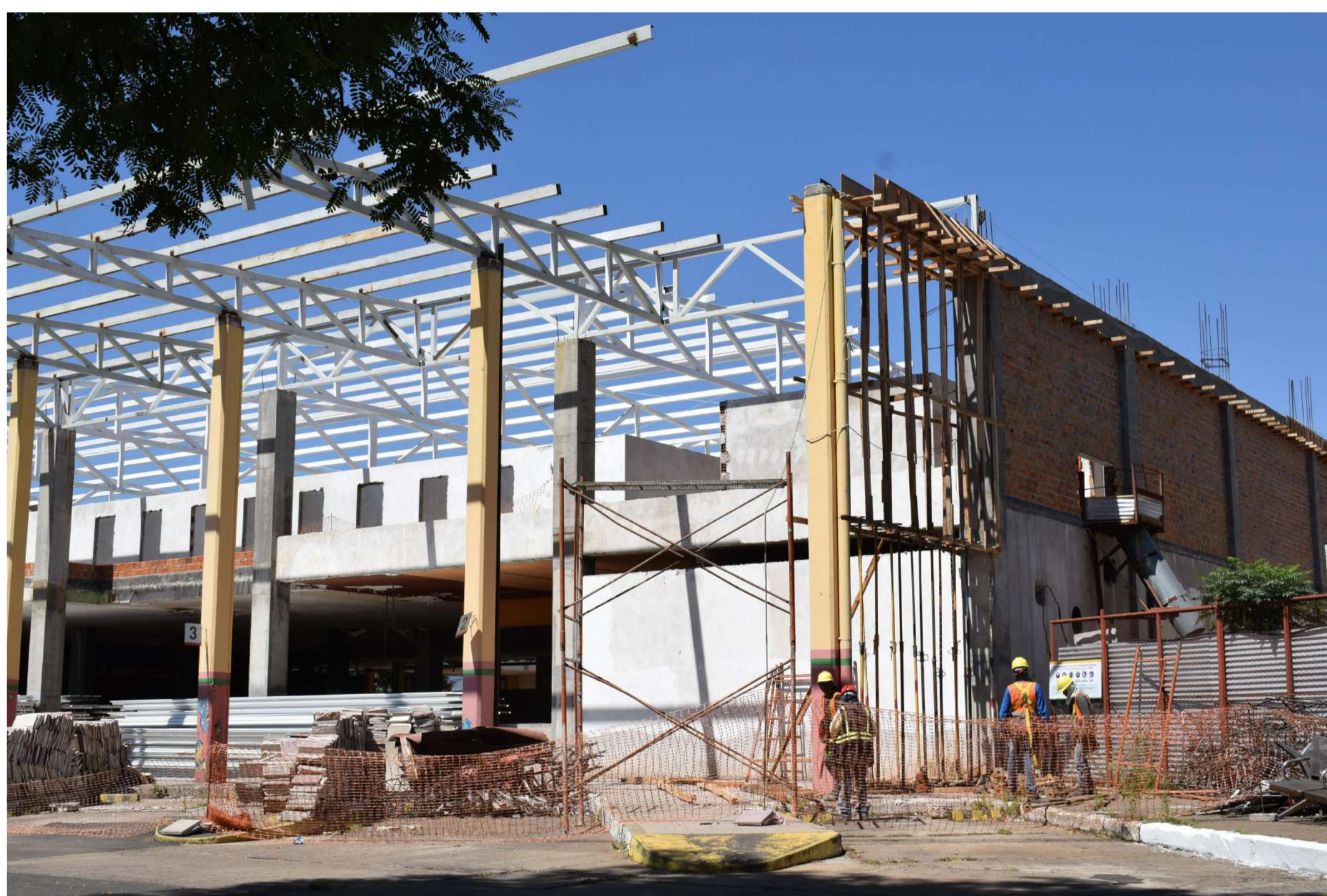
Obras de remodelación - Terminal de Ómnibus
