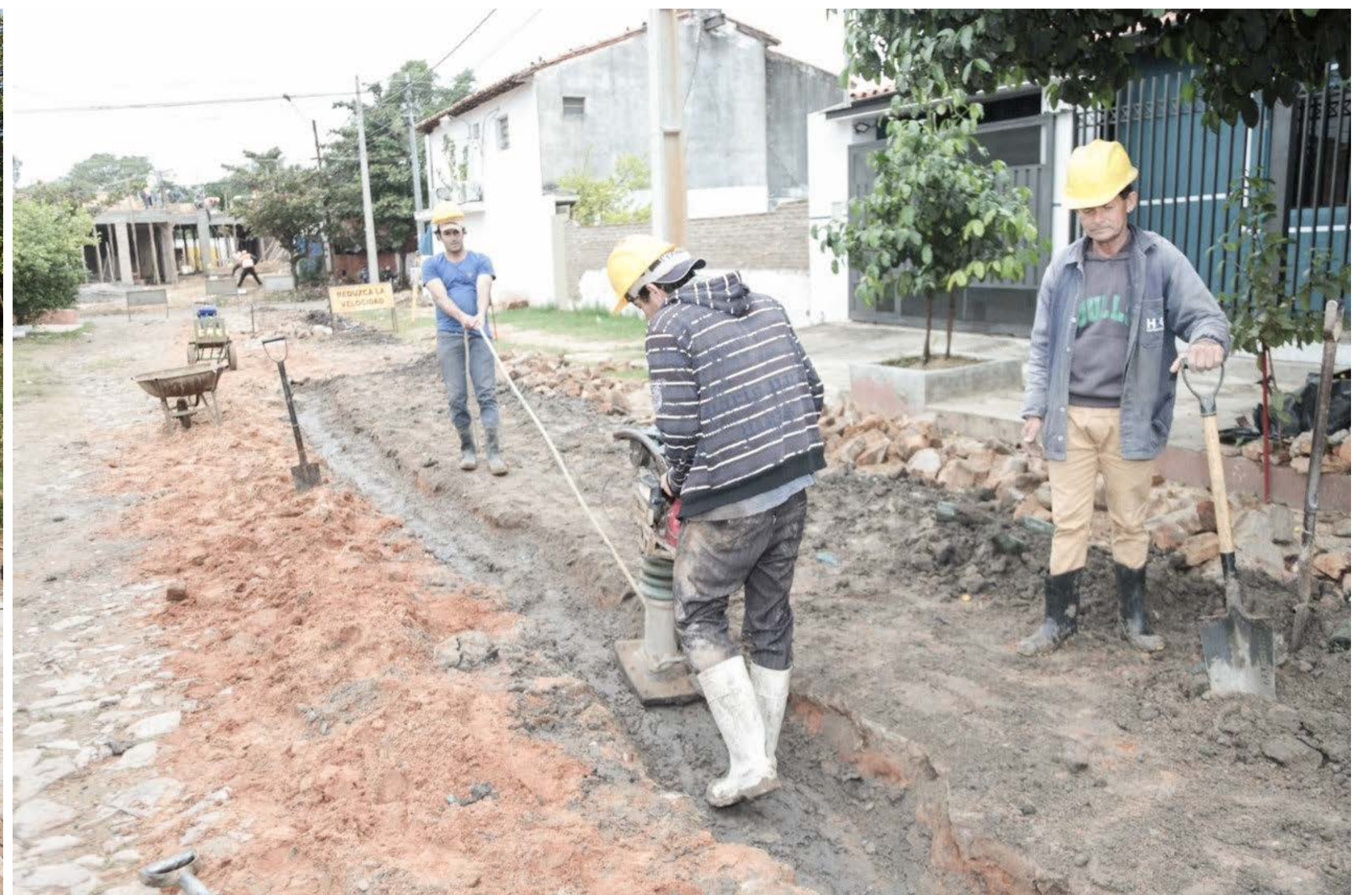
Alcantarillado Sanitario - Salvador del Mundo
