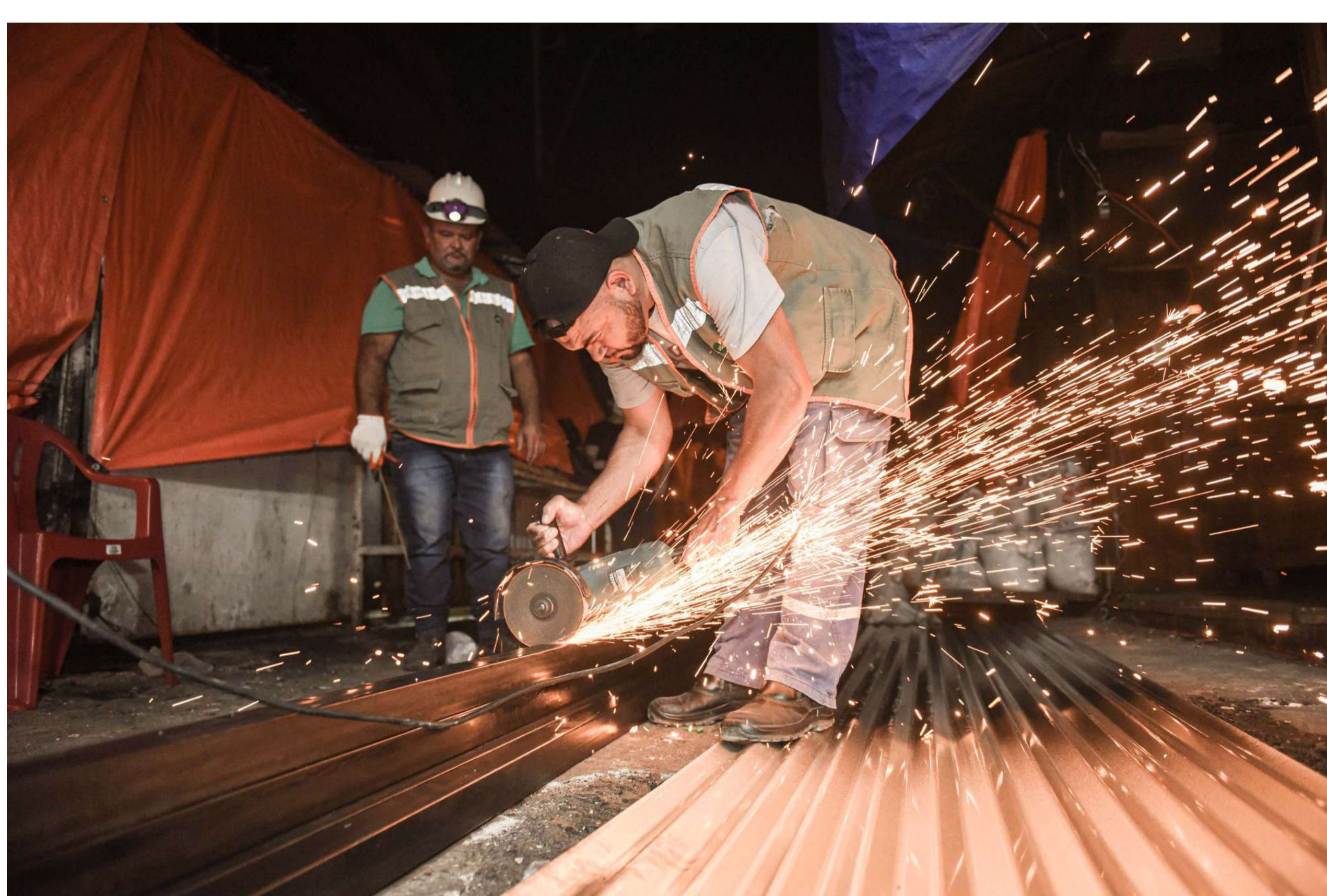
Mejoramiento de infraestructura - Mercado 4
