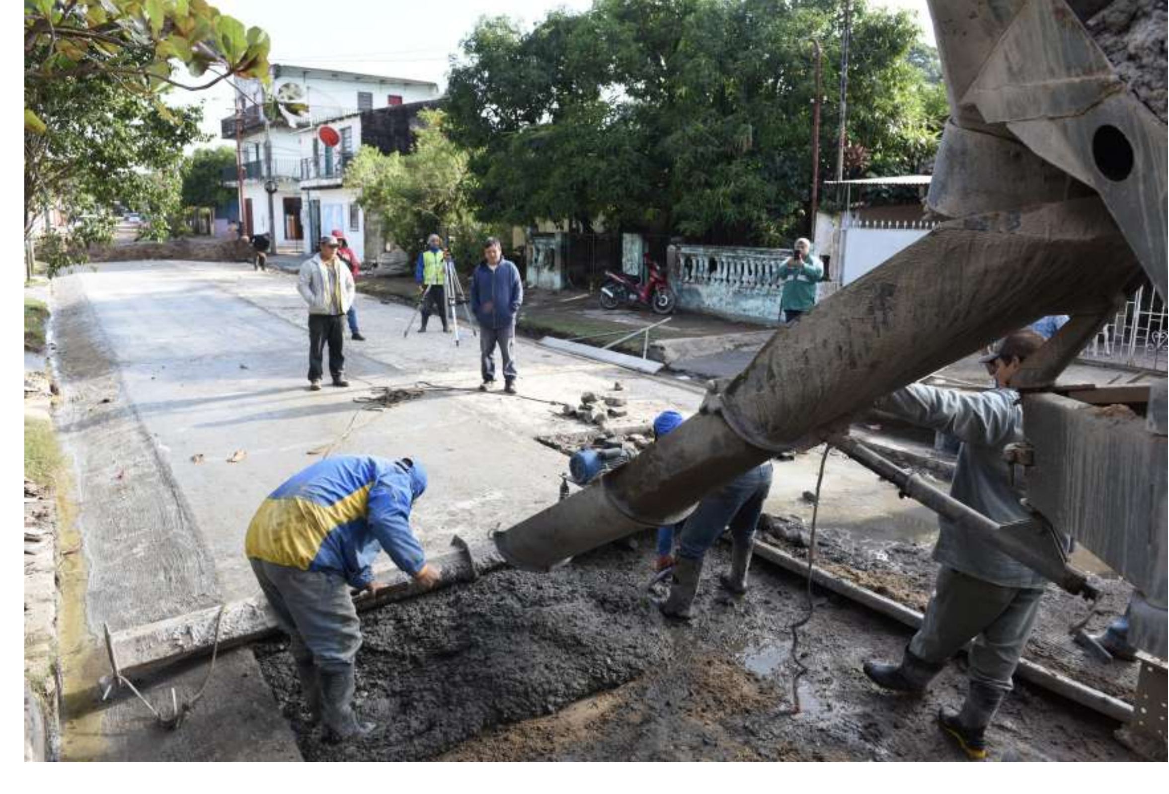
Mejoramiento Vial - Bañado Sur
