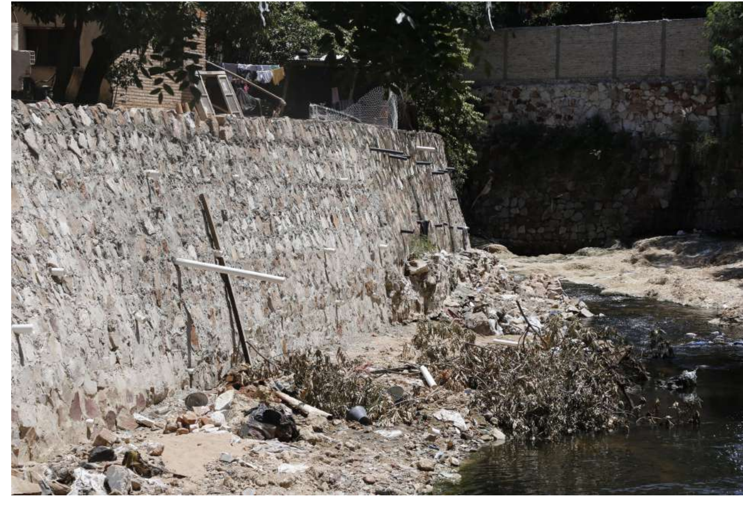
Muro de contención - cauces hídricos
