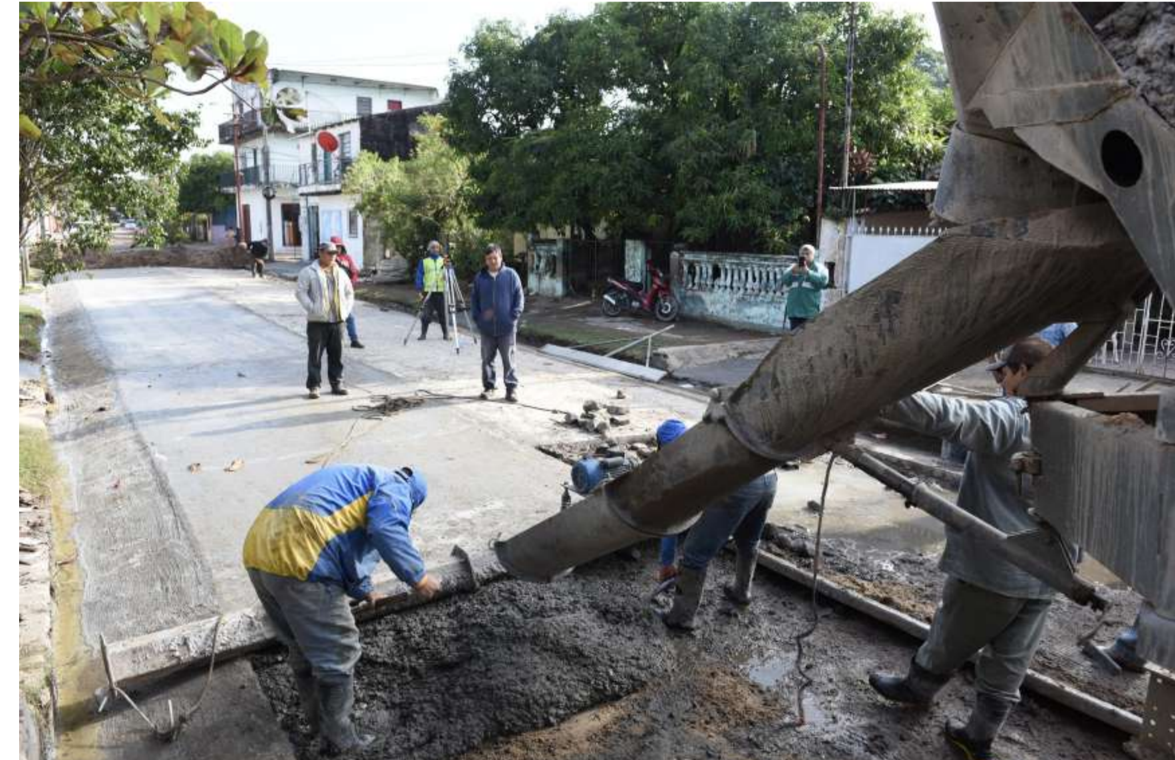
Mejoramiento Vial - Bañado Sur
