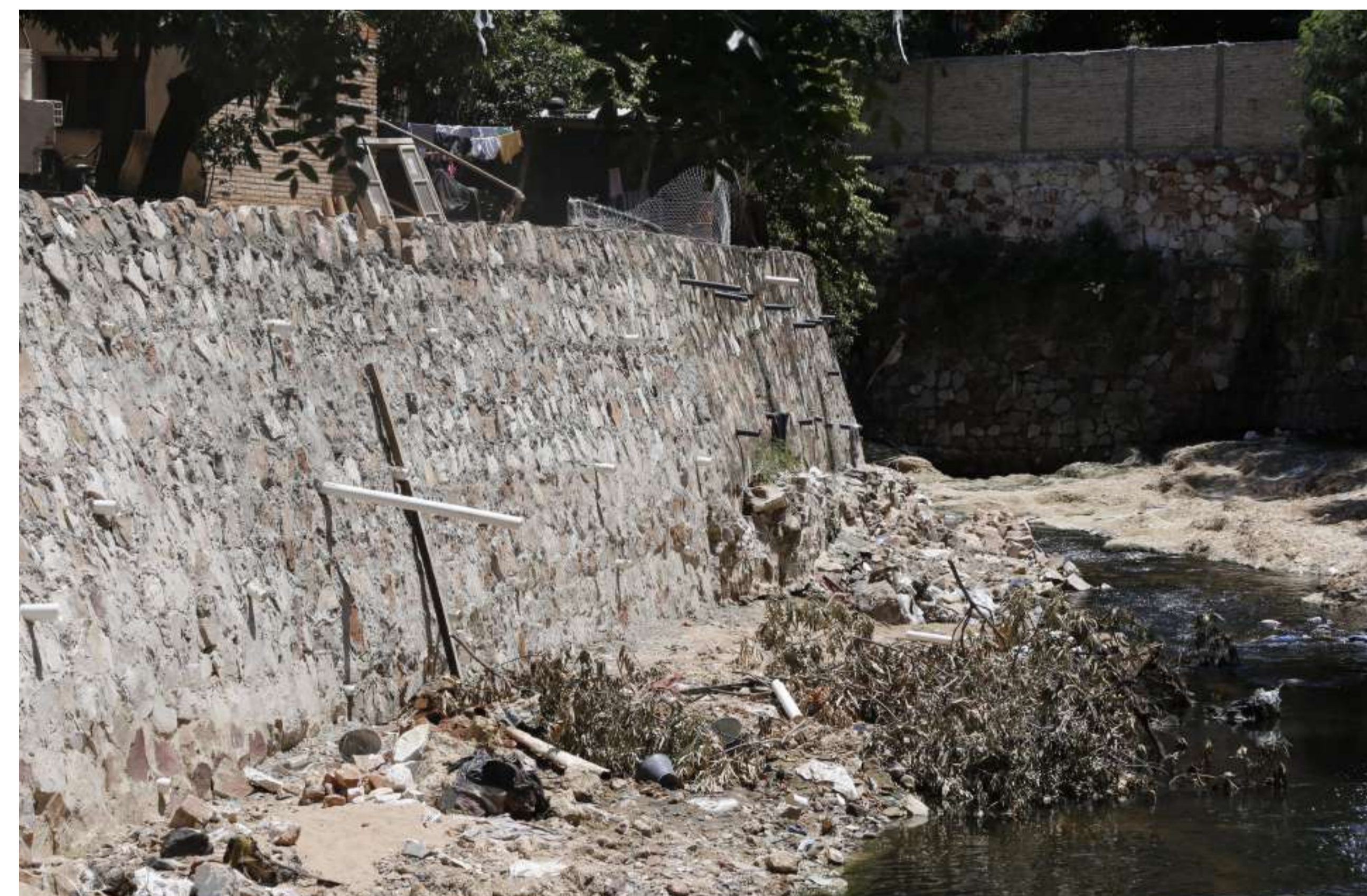
Muro de contención - cauces hídricos
