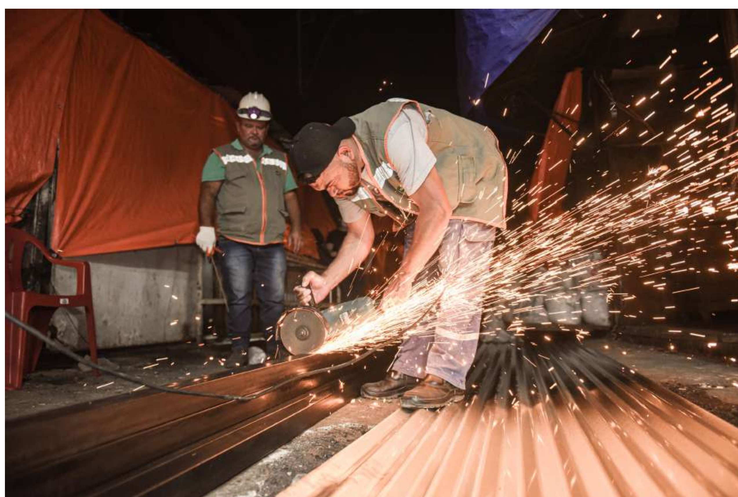
Mejoramiento de infraestructura - Mercado 4
